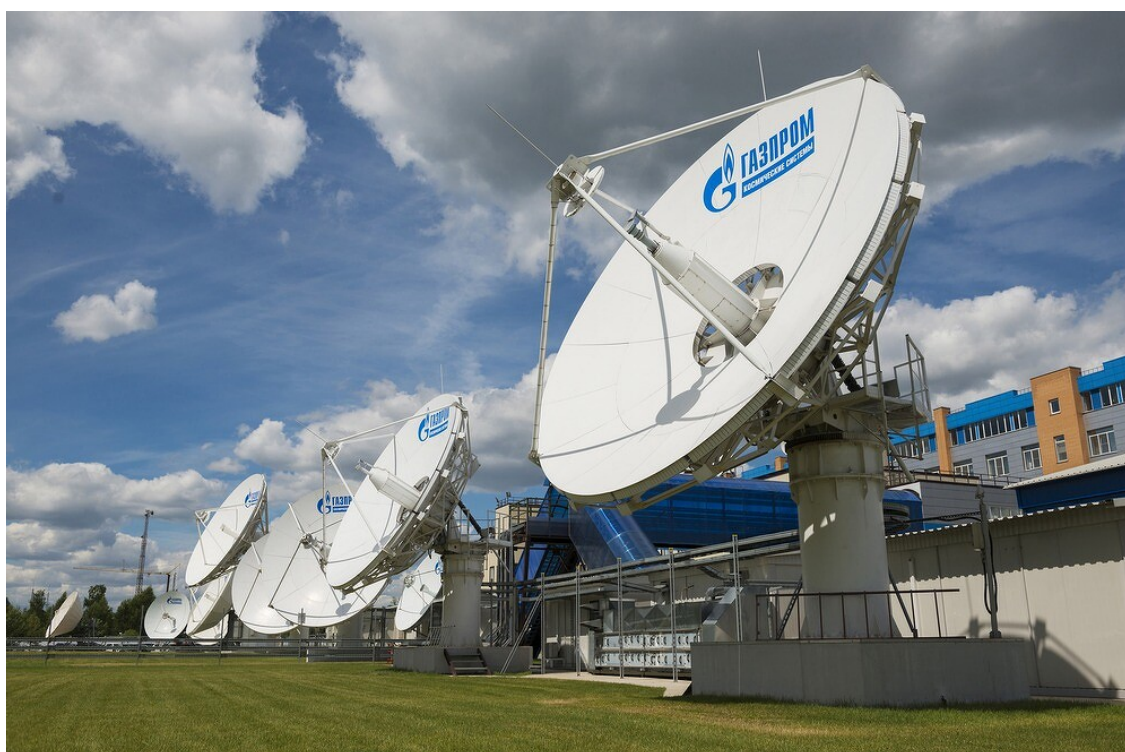
Телекоммуникационный центр «Щелково»
